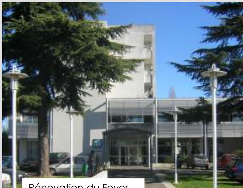
Rénovation du Foyer des Jeunes Travailleurs
