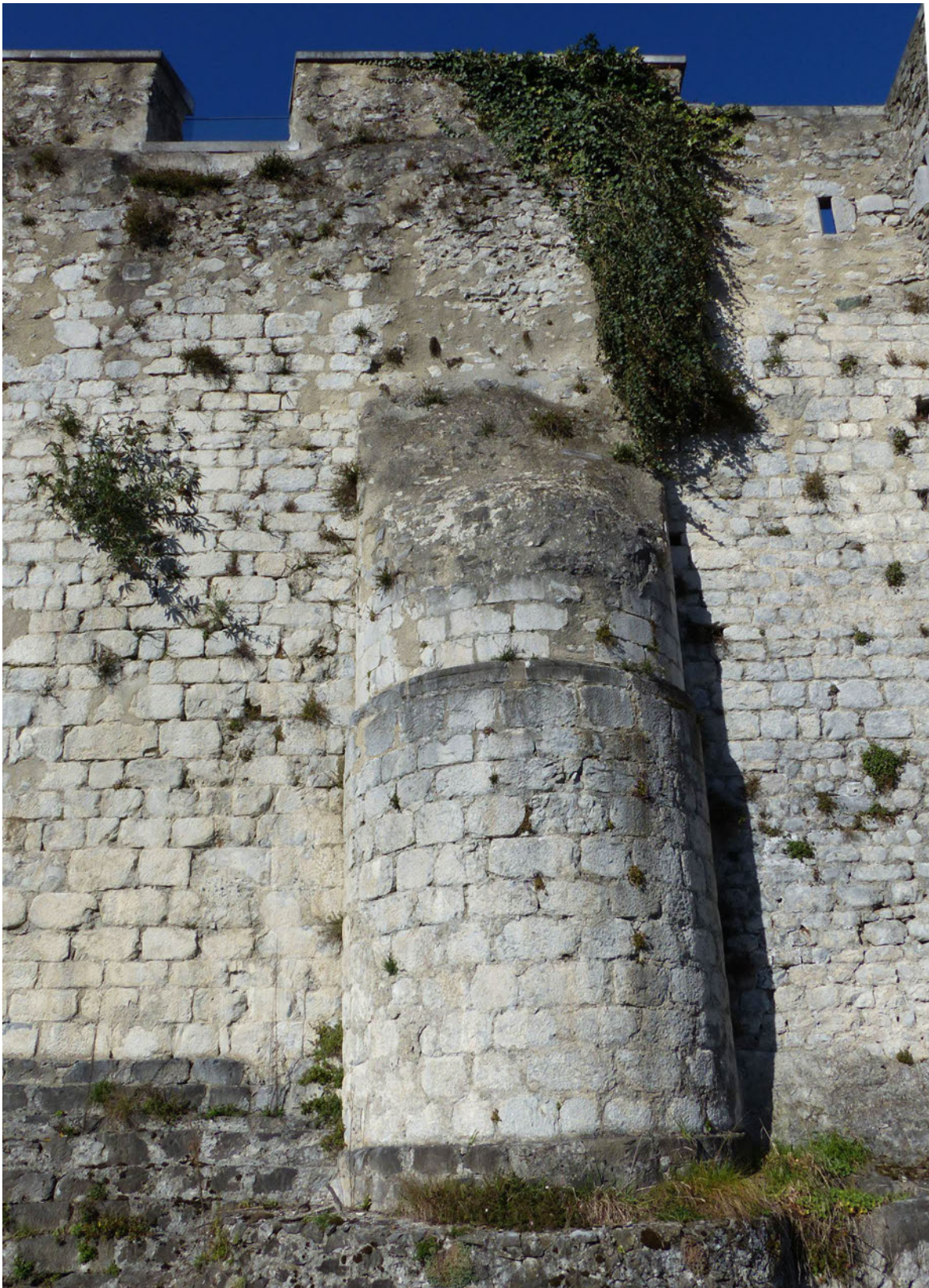
Appareils de la maçonnerie de la face est du cavalier sud. A droite, petit appareil du chemin de ronde, à gauche moyen appareil, strictement contemporain de la tour.
