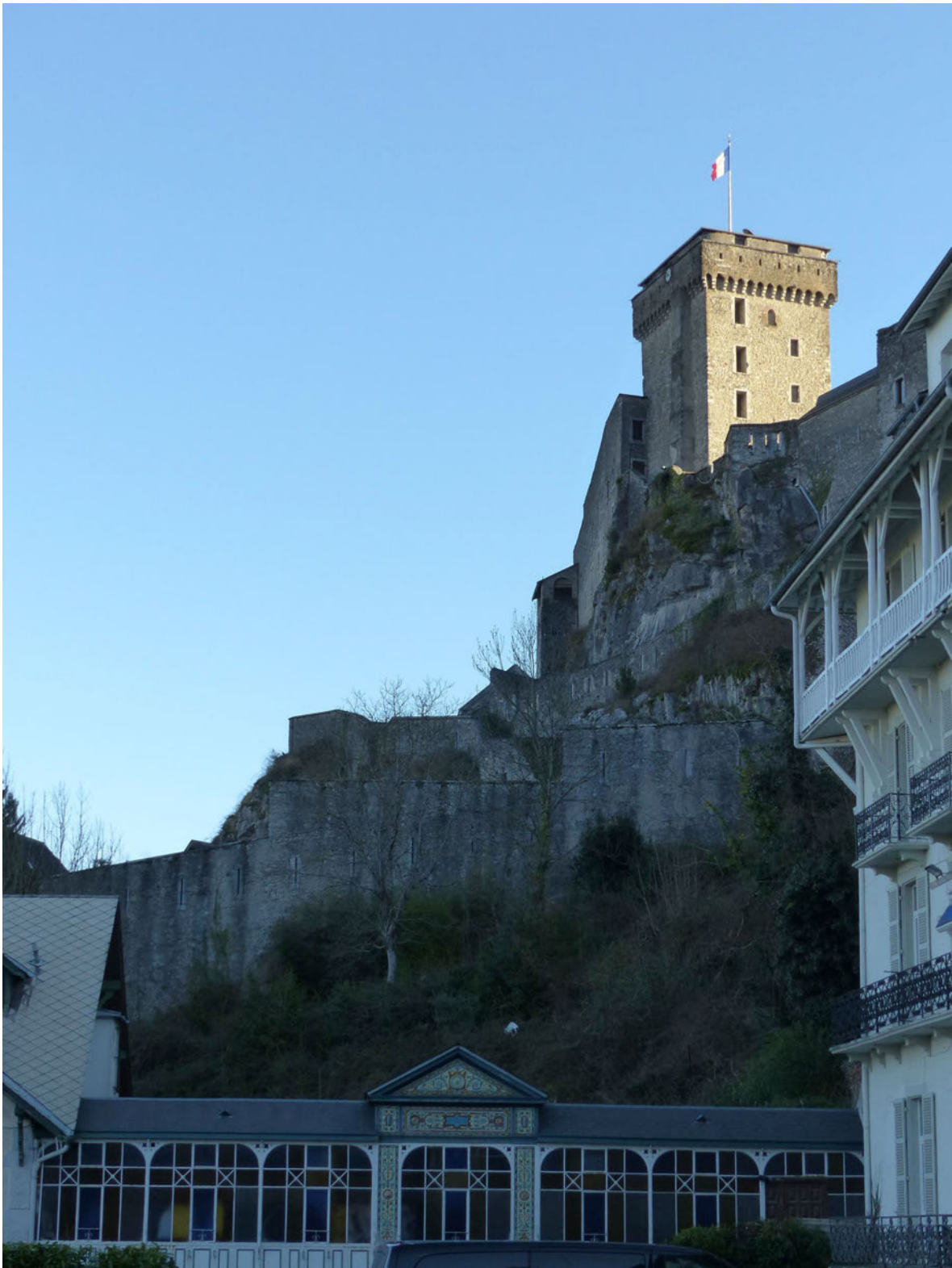
Vue générale de la forteresse de Lourdes, côté ouest. © Catherine Viers, Inrap
