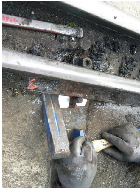
Remplacement des ancrages
