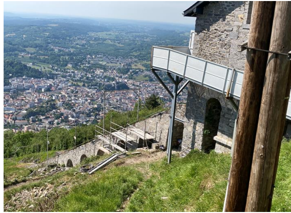
Echafaudages viaduc amont
