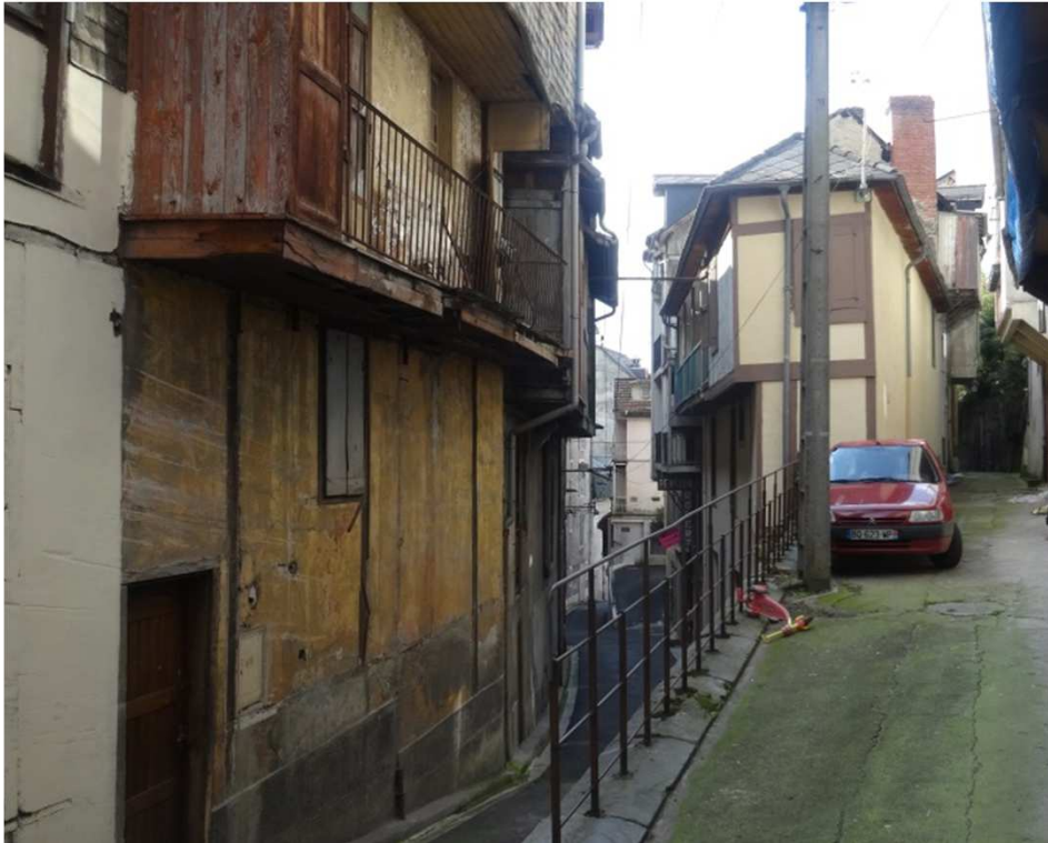
Petit bâti derrière le boulevard de la Grotte, rue des Cagots : mauvais état, mal logement, vacances ...
