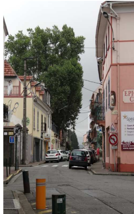
Rue du faubourg, vers l'est, maisons XVIIIe XIXe de type pyrénéen, problème des sols, des réseaux, de l'accessibilité...
