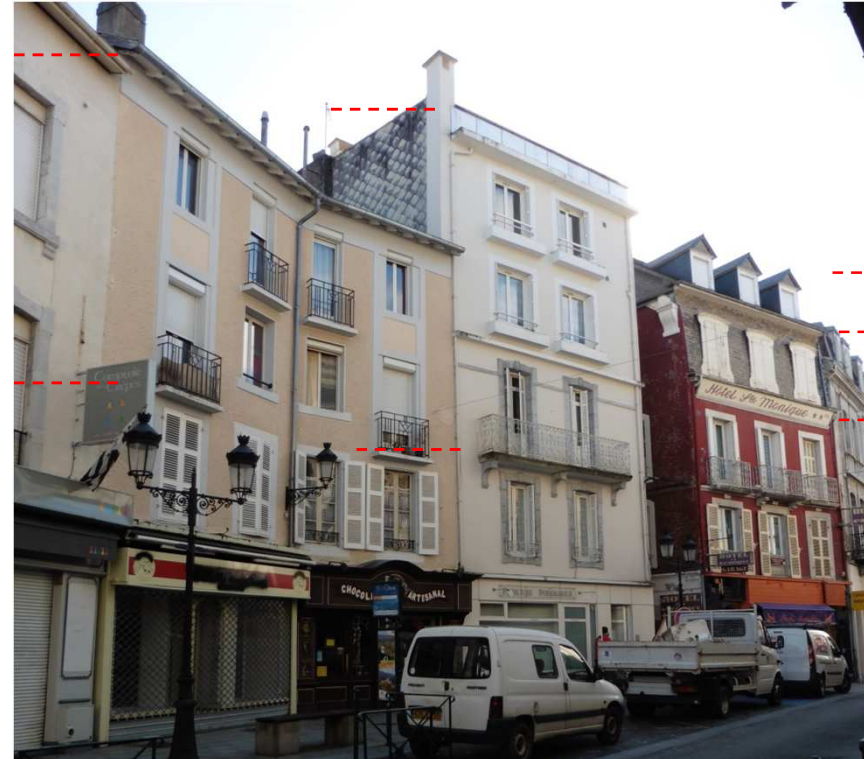
Rue de la Grotte: lecture de surélévations sur des maisons de bourg de R+1
